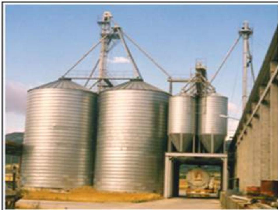
*1- silos de armazenamento de cereal; 2- silos de armazenamento de produto acabado (expedição granel)*
